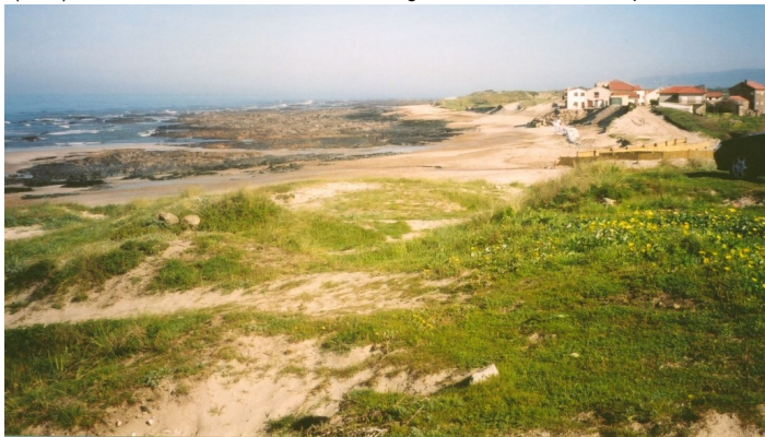
Figura 1: Praia de Mar, Junho de 2003. A norte da zona do galgamento (assinada pela seta) observam-se os sacos, com areia e seixos, colocados na base da arriba (em Fevereiro de 2003) e um pequeno enrocamento, feito com blocos de granito.
